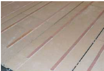
① パーチ上に小根太施工
