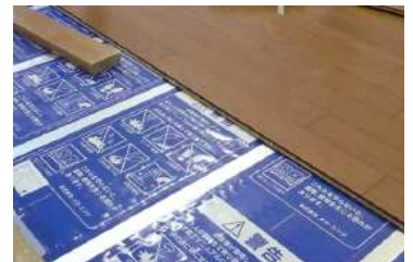
④ フローリング施工
