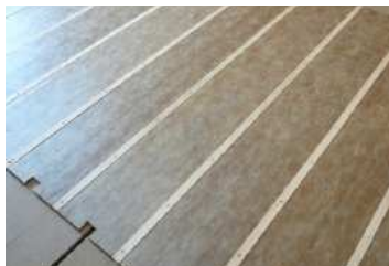
② 根太間に断熱材施工
